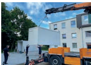
Aufstellen der Wohncontainer vor dem Studentenwohnheim Edo-Osterloh-Haus in Kiel.
